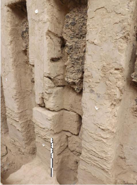
**Figura 8.** Detalle de rotura de adobes y enlucidos para habilitar la construcción de hornacinas en la entrada del palacio Gran Chimú. Foto del PECACH. (Color en la versión electrónica)
