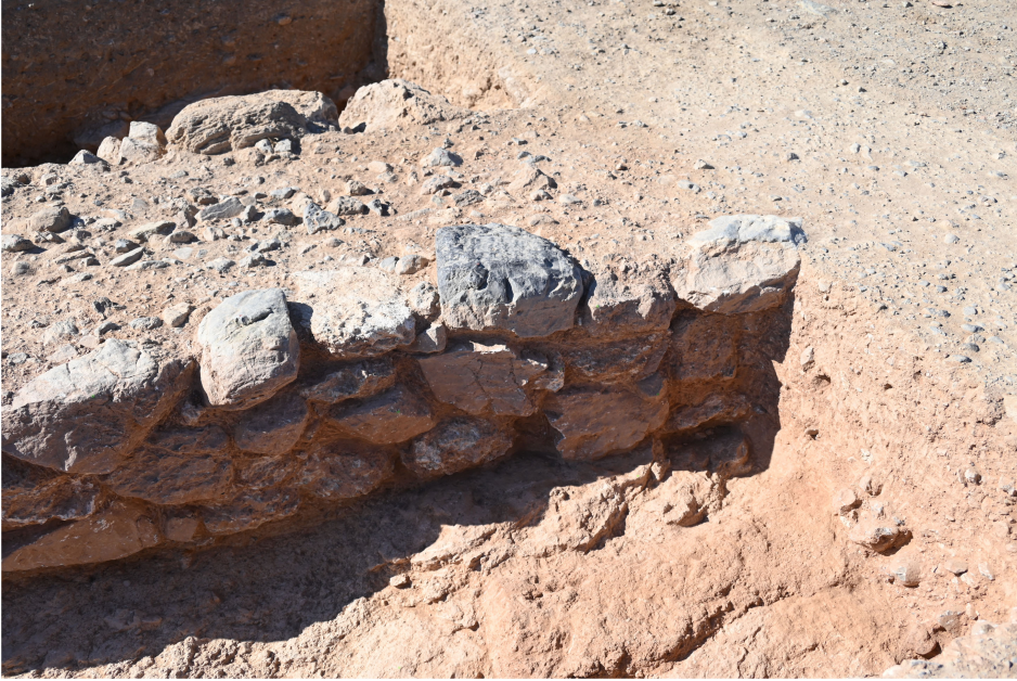
Fig. 3.75. Itanos: the exterior of a section of the city wall. © Mission archéologique d'Itanos 2023.
